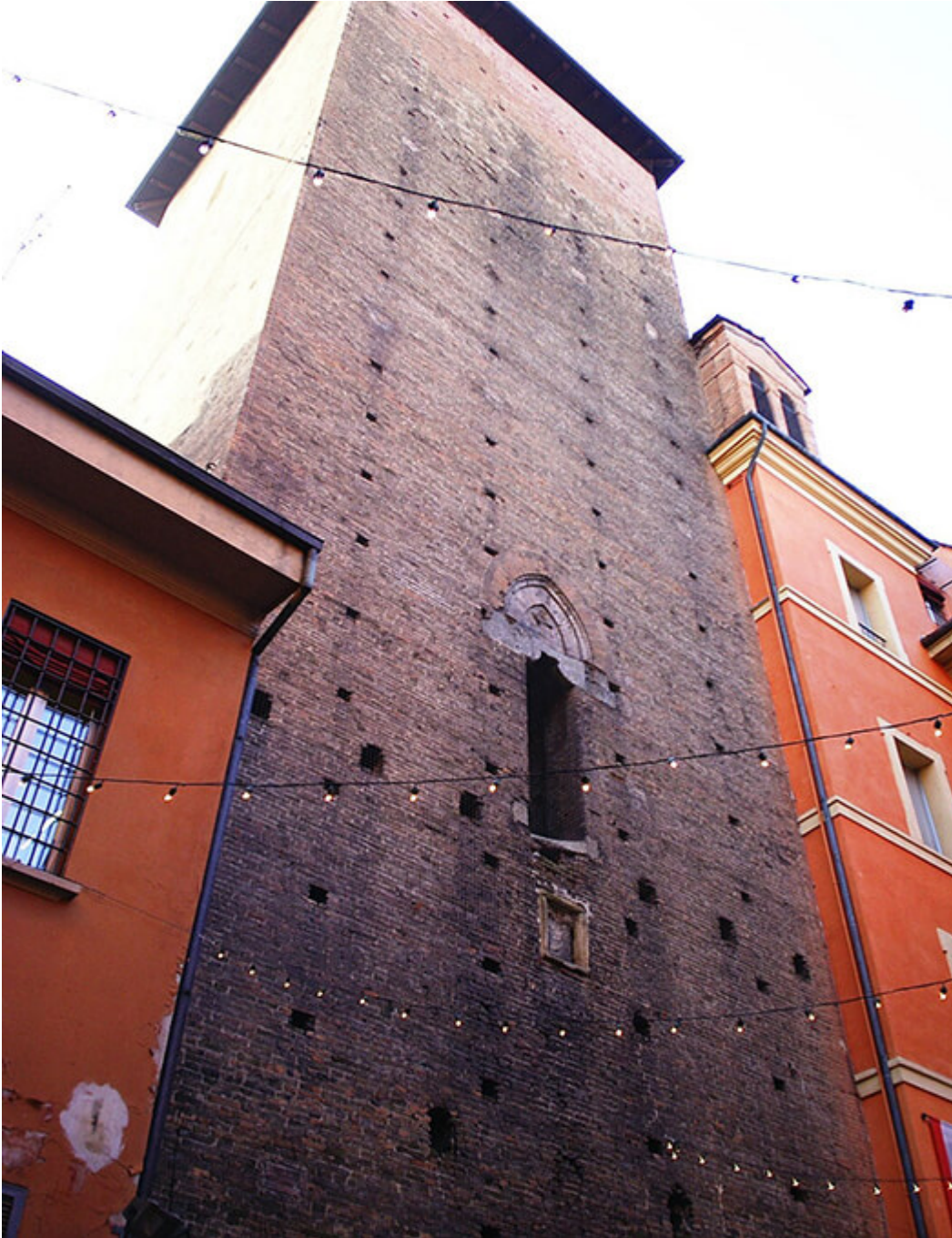
Vista laterale di Torre Galluzzi.
